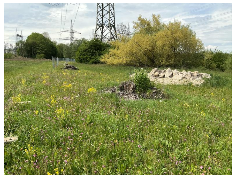
Bereits entwickelte artenreiche Frischwiese mit Reptilienstrukturen im Norden des Umspannwerks
