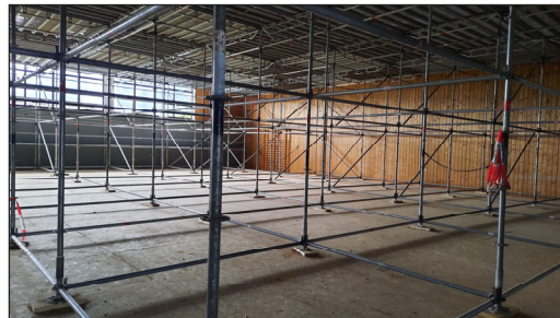
Bild oben: Die westliche Hallenseite ist derzeit ohne Fenster. Die Geräteräume wurden abgerissen. Bild rechts und unten: Der Innenbereich der Heinrich-Loder-Halle ist komplett eingerüstet.
